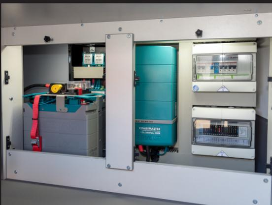
Sichere, netzunabhängige Stromversorgung über eine Lithium-Ionen-Batterie und den CombiMaster von Mastervolt.
