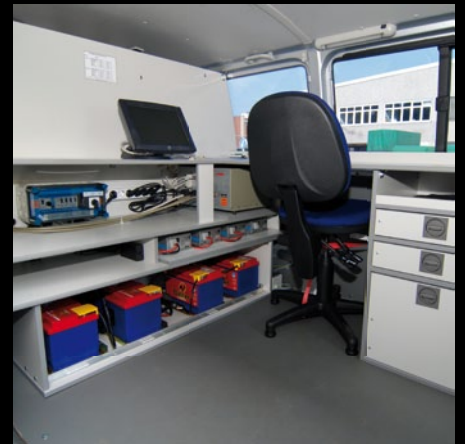
Stromversorgung und Arbeitsplatz in einem Verkehrsüberwachungsfahrzeug
