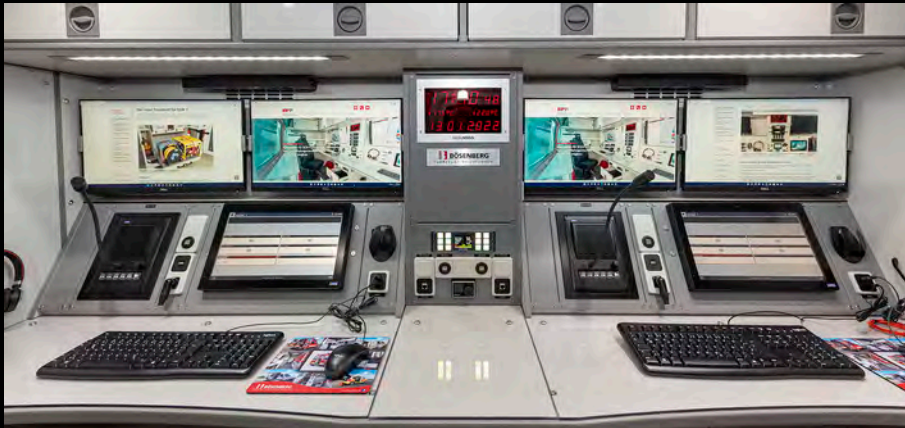
Zwei Funkarbeitsplätze mit 4x Tetra MRT, gesteuert über LARDIS®, Telefonanlage und PCs. Voll-digitale Steuerung und Überwachung aller Funktionen der Stromversorgung.
