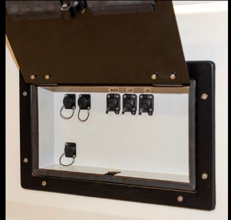
Außenanschlusskasten mit LAN und WAN-Ports.
