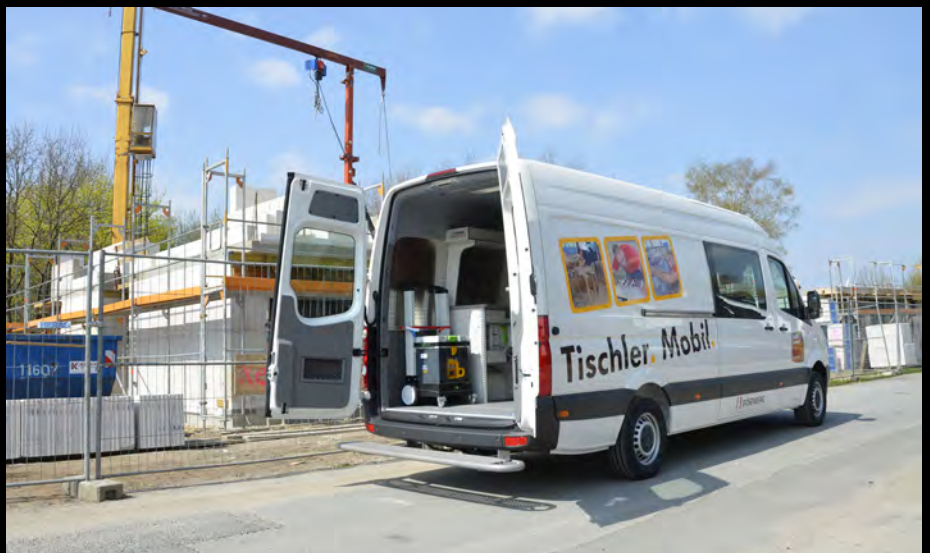
Das TischlerMobil im Einsatz auf der Baustelle
