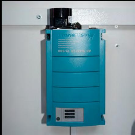
230 V Wechselrichter mit 500 Watt Leistung und integrierter Steckdose.
