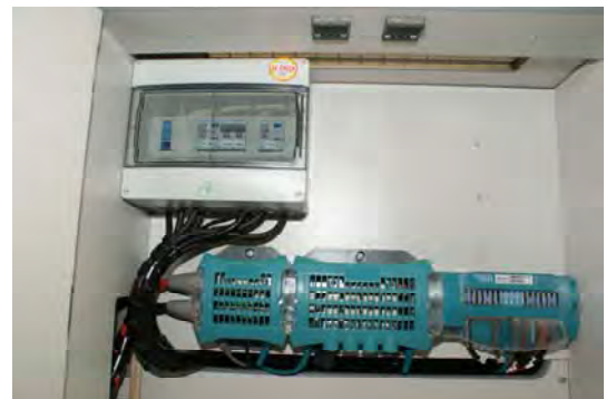
CAN-Bus Komponenten, Shunt, Verteilung
